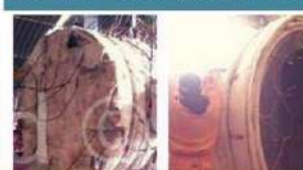
Servicio de Relevado de Esfuerzos Via Resistencias a un Cambiador de Calor de 6" de Espesor.
