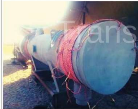
Relevo de Esfuerzos a 110 Dobles en "U" de Tubería para un Haz de Tubos.
