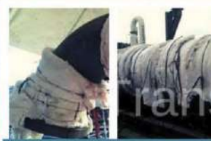
Relevado de Esfuerzos a Tubería.
