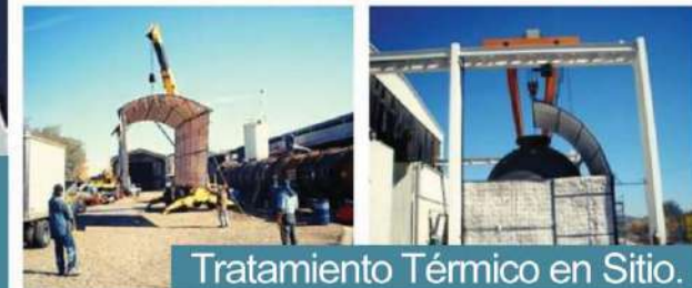
Tratamiento Térmico Realizado a 2 Torres de 30 Mts cada una.
