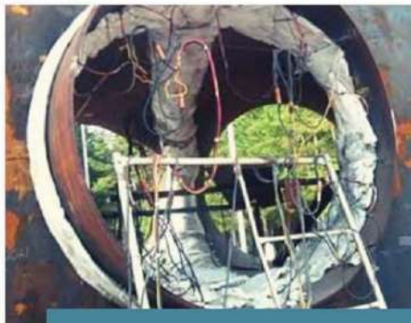
Postcalentamiento vía Resistencias a 5 Yees y una Equis para Tubería del Multiple de Descarga Realizados en las Instalaciones de CONAGUA.
