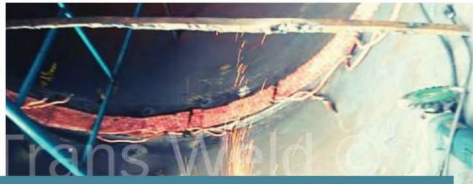
Postcalentamiento vía Resistencias a 5 Yees y una Equis para Tubería del Multiple de Descarga Realizados en las Instalaciones de CONAGUA.
